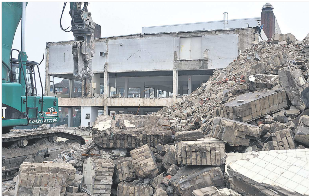
Vom ehemaligen Autohaus Burr steht nur noch das Gerippe. Bis zum Spätsommer sollen die ersten Bauabschnitte des neuen „Quartierszentrum Gröpelingen“ bereits bezugsfertig sein. Fotos: Bahlo
